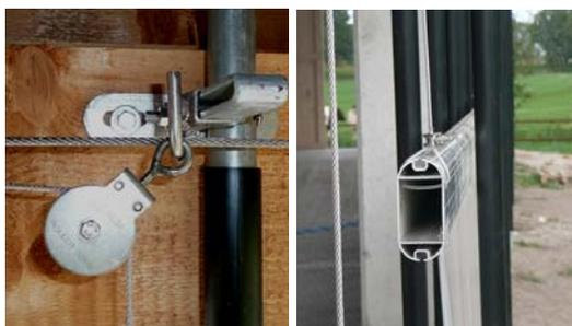
Расстояние между ограничительными тросами/трубами необходимо подогнать по месту строительства в зависимости от конструкции здания, региона или расположения проемов (ветр. нагрузка).
