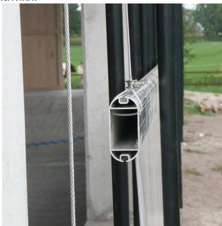
Расстояние между ограничительными трубами необходимо подогнать по месту строительства в зависимости от конструкции здания, региона или расположения проемов (ветр. нагрузка).
