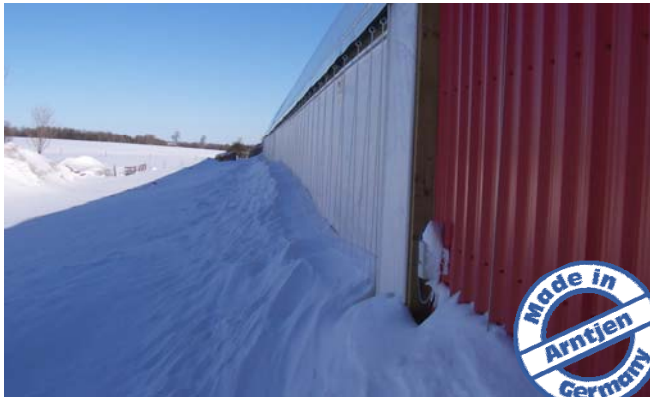
Шторы: Открываются сверху, скручиваясь вниз
