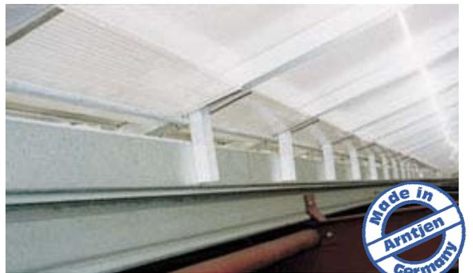
Конек с вентиляционными клапанами
